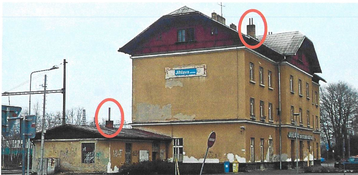
Foto č. 4 – Výpravní budova. Azbestocementové roury jako komínové nástavce.
