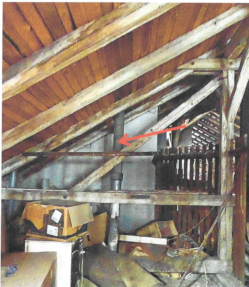
Foto č. 6 – Výpravní budova, půda. Azbestocementové potrubí pravděpodobně odvětrání kanalizační stoupačky.
